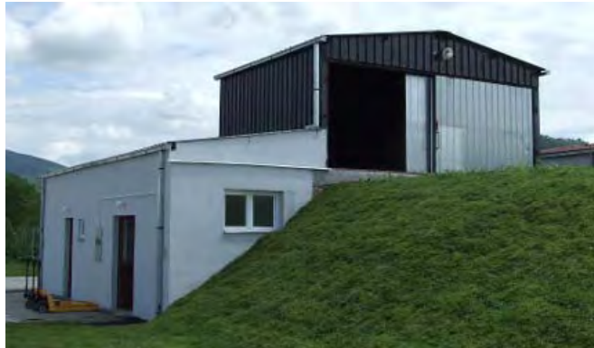
Слика 37. Сабирни пункт (хладњача) за привремено складиштење кланичког отпада у Вршцу
