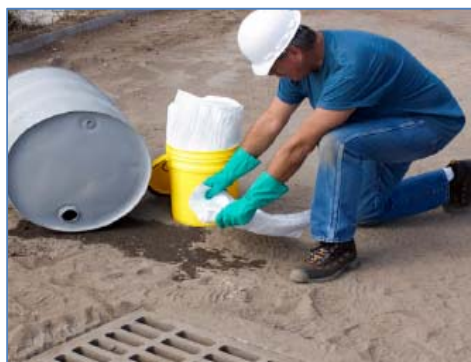
Slika 5. Sanacija malih incidentnih curenja
